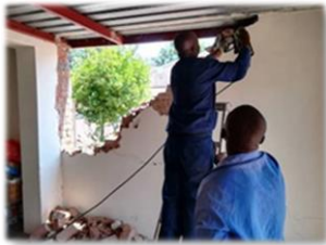
家裡車庫 8 月被撞壞的牆 保險公司終於維修了
